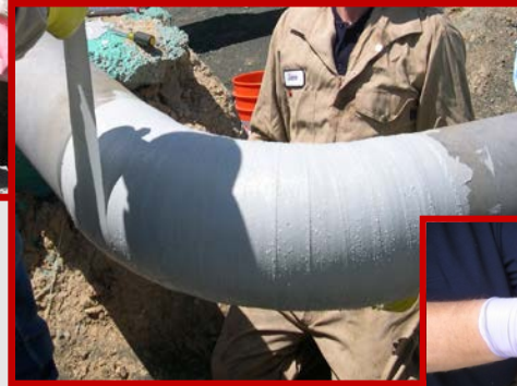
Wrap the Pipe
